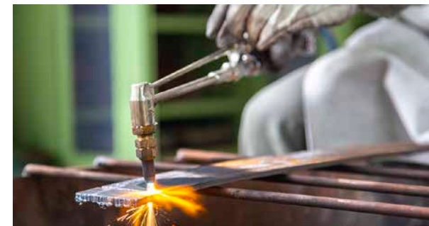
溶接などの資格も取れるのがポイントです
